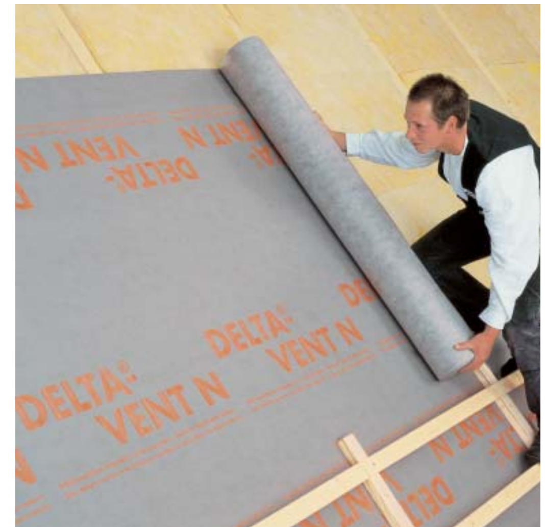
A DELTA®-VENT N 3 rétegű alátétfedés különlegesen könnyen beépíthető.
